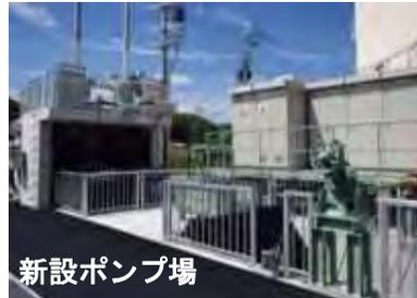
今回の豪雨では、7/5～7/8の4日間で59時間にわたりポンプを稼動。約7.8万m<sup>3</sup>の内水を排水し、ポンプ場整備が浸水被害の軽減に大きく貢献。
